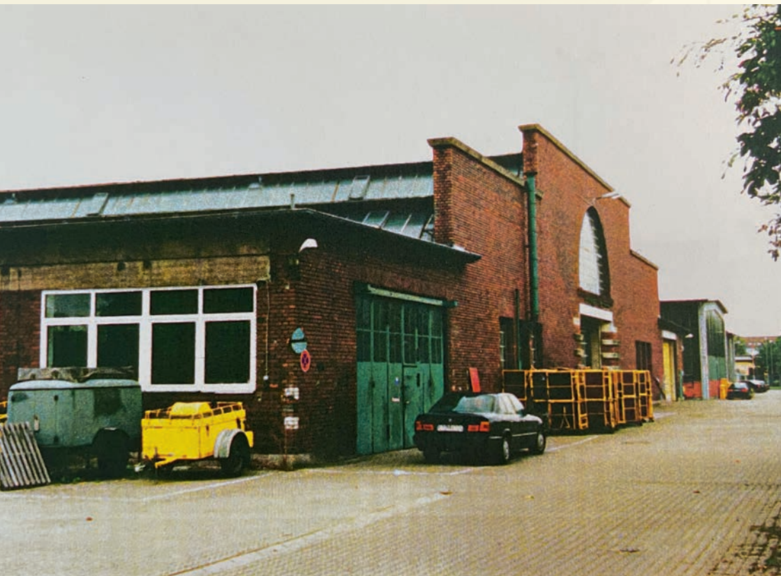
Die große Werkhalle kurz vor ihrem Abbruch.
