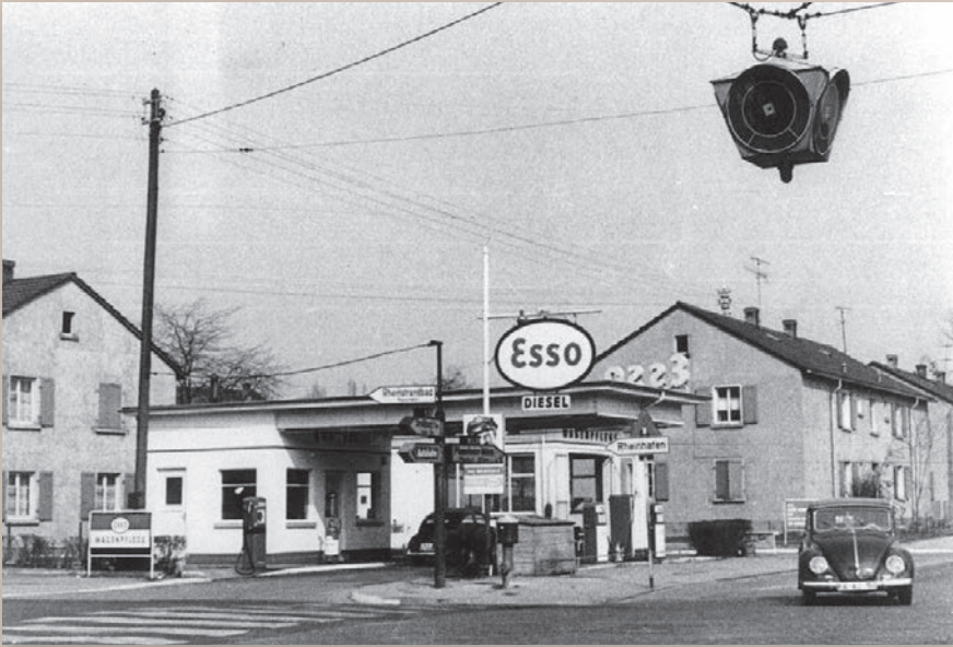
...aufgenommen 1962, an der Kreuzung Durmersheimer Straße/Zeppelinstraße. Die Heuer-Ampel war eine der ersten Signalanlagen, die über der Mitte einer Straßenkreuzung an Drahtseilen befestigt war und mit roten und grünen Kreissegmenten und einem sich drehenden Zeiger die jeweilige Rot- beziehungsweise Grünphase anzeigte.
