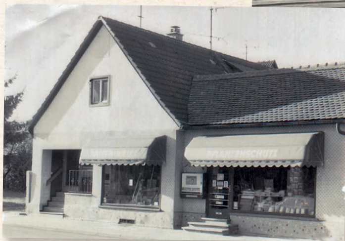
l.: Die beiden Läden für Futtermittel und für Haushaltswaren wurden miteinander verbunden.
