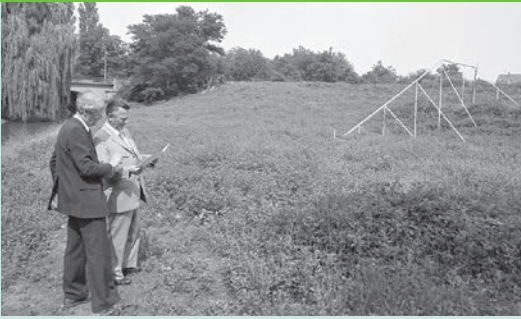
Blick auf das Baugelände 1970. Oberbaudirektor Dr. Egon Martin (dunkler Anzug) und Bürgermeister Paul Hugo Jahn (heller Anzug) bei Einsichtnahme in Pläne. Im Hintergrund ein Phantomgerüst für die projektierte Bebauung.
