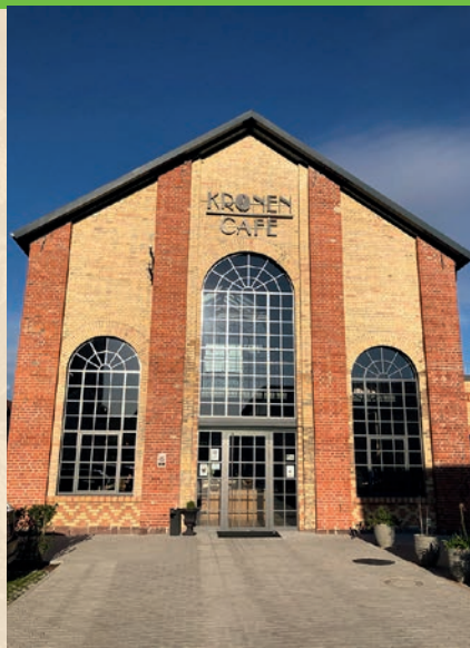
Die Fassade des umfangreich sanierten Ziegelstein-Gebäudes, in dem heute das Kronen Café seinen Sitz hat (heutige Adresse: Bannwaldallee 38b).
