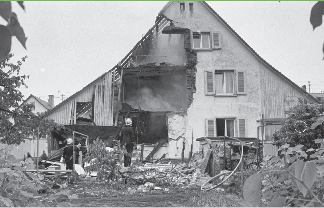
Selbst bis zur Rückseite des Hauses wirkte die zerstörerische Wucht des Brandes.
