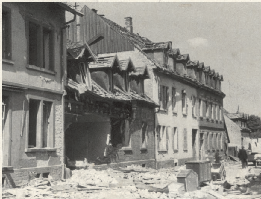
Nach einer Bombennacht wurden aus den zerstörten Häusern die noch brauchbaren Möbelstücke auf die Straße gestellt.
