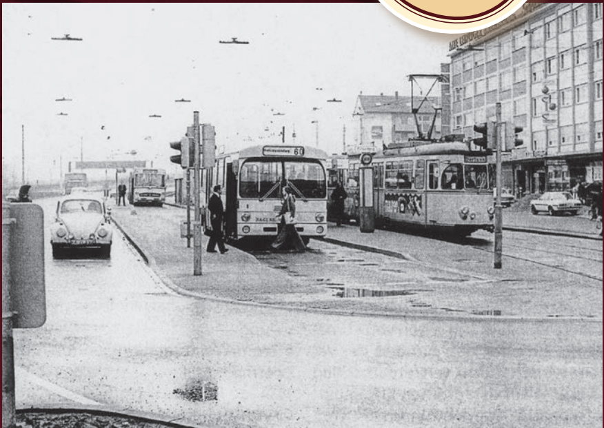
Mit der Schaffung einer Busspur unmittelbar parallel zur Straßenbahnhaltestelle wurde am Entenfang ausreichende Verkehrssicherheit für Umsteiger geschaffen. (1977)
