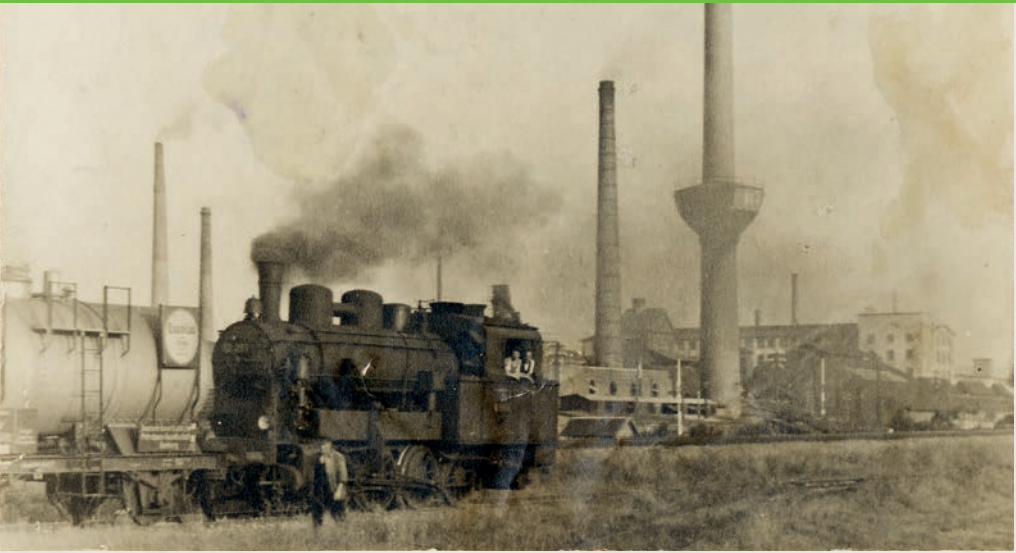
Ansicht des Gleisanschlusses in der Bannwaldallee mit einer Dampflokomotive, im Hintergrund die Fabrikanlage.
