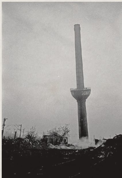
l.: Gesamtansicht des Industriekamins im Augenblick der Sprengung r.: Blick auf das Mauerwerk des gesprengten Industriekamins mit Firmenschrift. Im Vordergrund Sprengmeister Jacob mit Werkzeug in der Hand.
