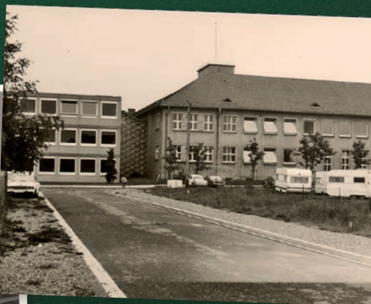
1965/1966 wurde die Schule um einen Anbau erweitert
