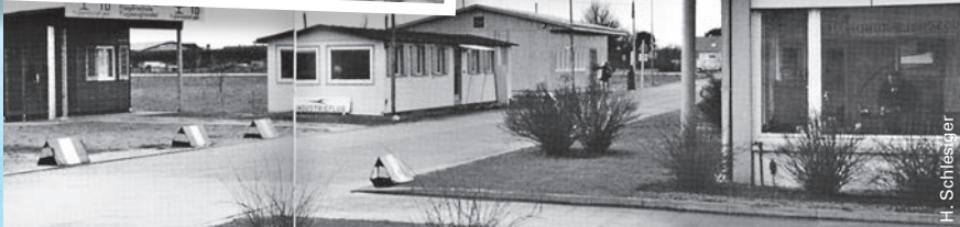
Einweihung des Flughafens 1957 durch Günther Klotz Alter Tower mit provisorischen Bürobaracken
