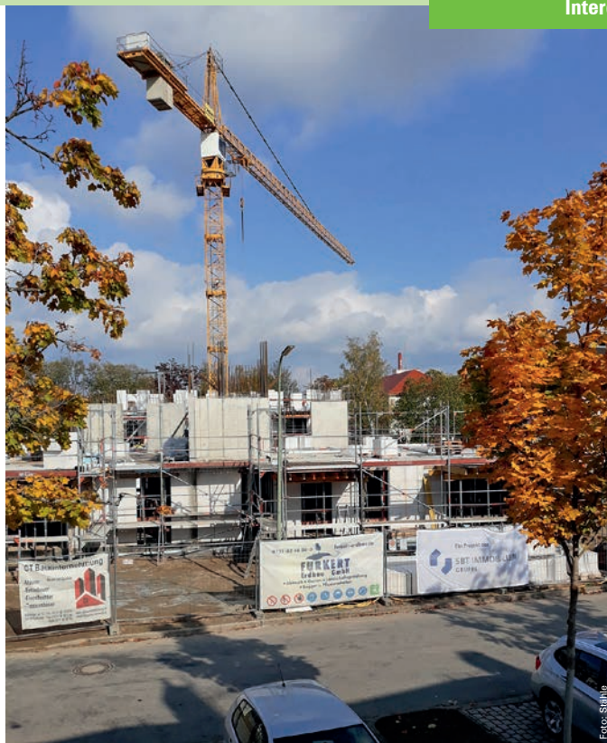
Bauvorhaben Neubau Edelbergstraße (auf dem Gelände des ehemaligen Pflegeheims St. Bernhard), aufgenommen Mitte Oktober 2020
