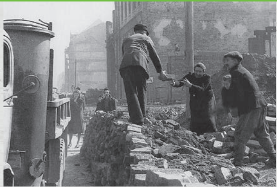
Trümmerbeseitigung war auch in Karlsruhe zunächst das oberste Gebot in der Nachkriegszeit. Alle halfen mit – aus Schutt wurde Baumaterial für den Wiederaufbau.
