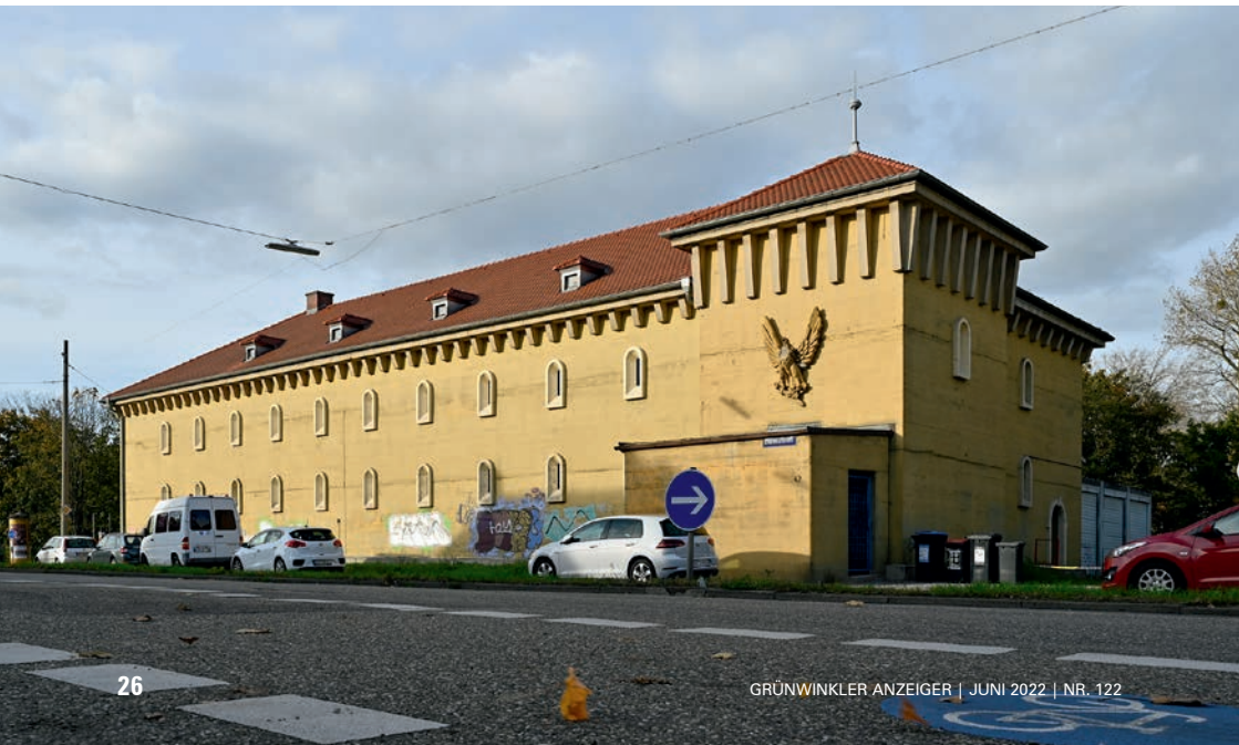
Der Hochbunker in der Rheinhafenstraße.
