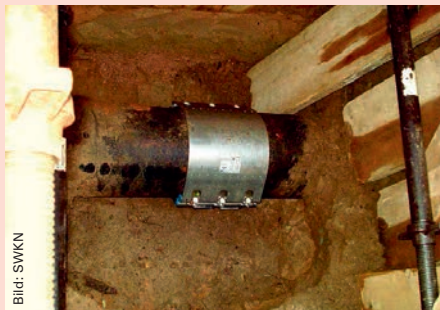
Wasserrohr mit einer Dichtschelle repariert
